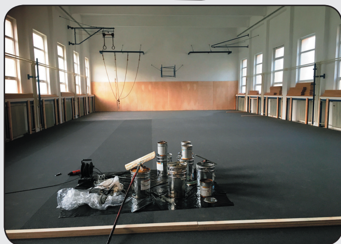
5. Pokládání gumové vrstvy
